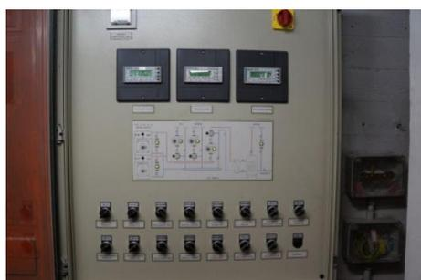
Figura 4.7 – Particolare della centralina di controllo in CT
